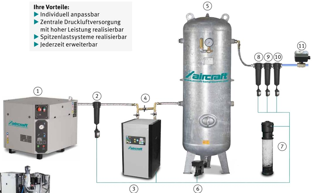
Direkt dem Kolbenverdichter nachgeschaltet ist der Wasserabscheider zur 99%-igen Vorabscheidung von Wasser. Dies entlastet die nachgeschalteten Geräte.
